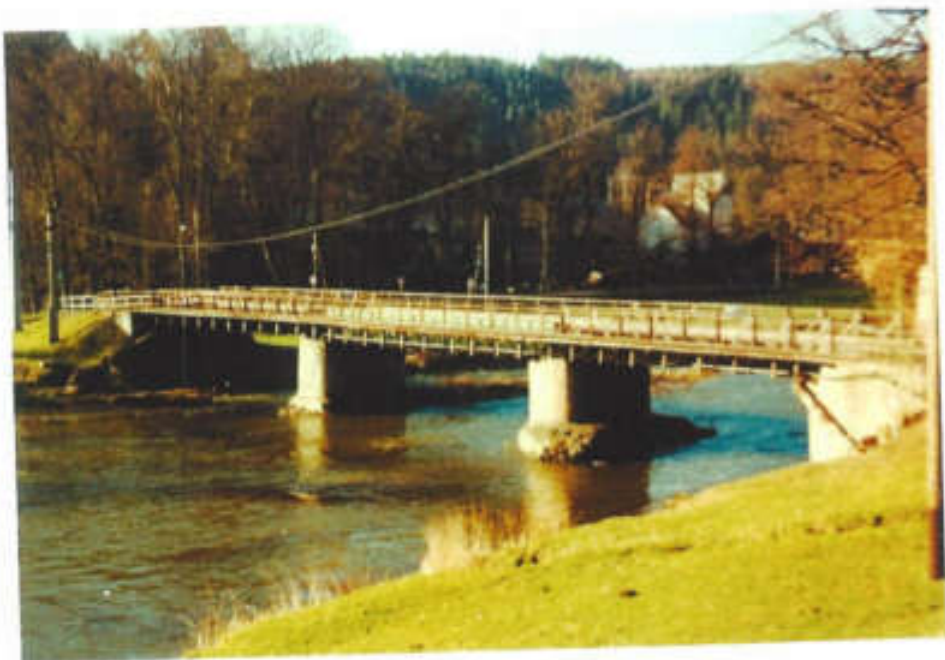
Mit erneuertem Mittelteil bis 2003 dem Verkeher standgehalten
