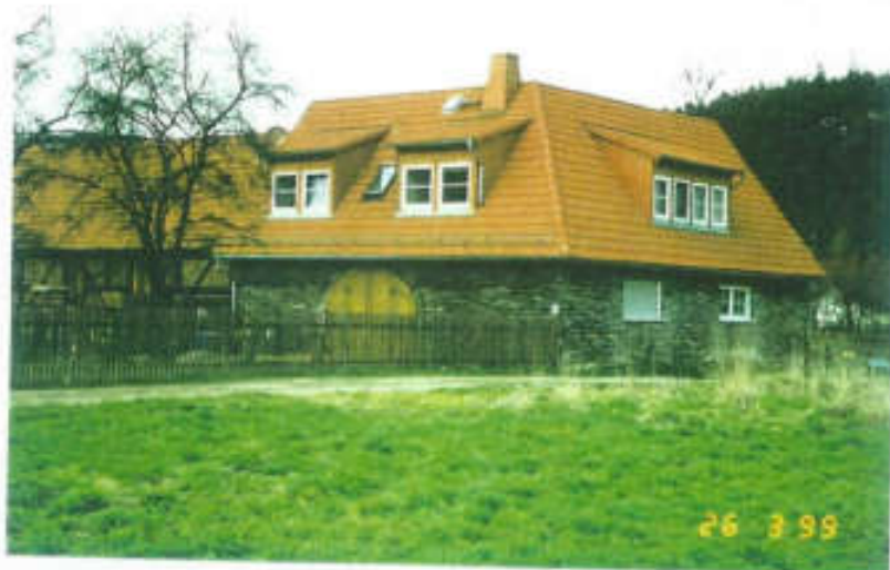
Umgebaute, frühere Wirtschaftsgebäude
