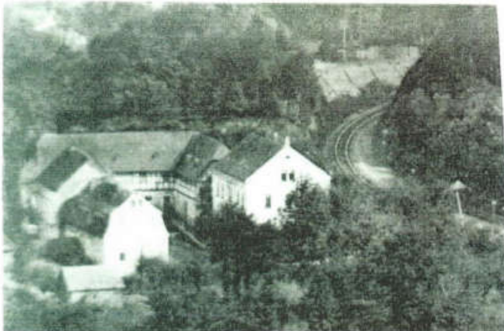
Gesamtansicht "Neue Mühle" - noch mit altem Mühlengebäude
