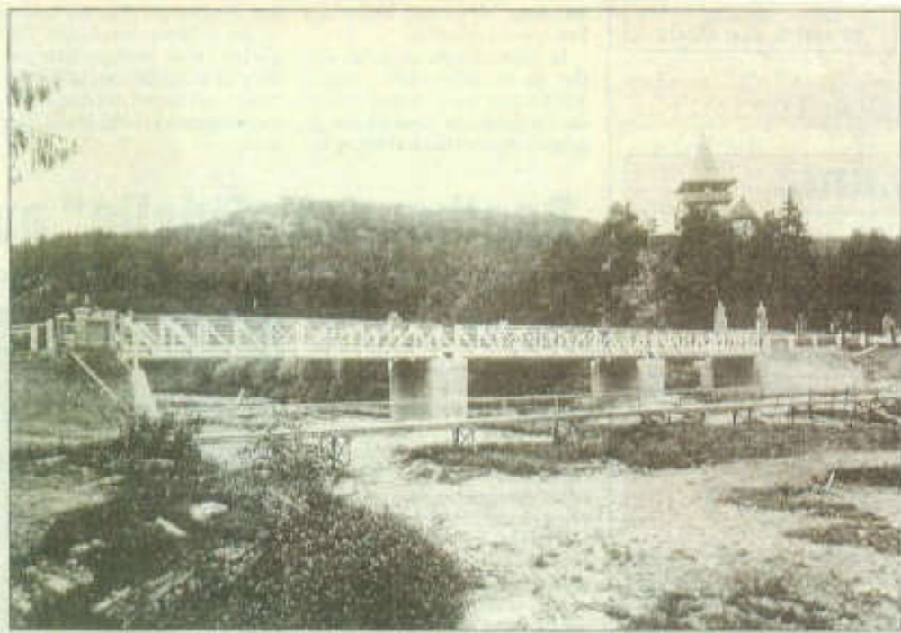
Die vollendete neue eiserne Brücke mit dem Notsteg konnte am 5. September 1892 für den Verkehr frei gegeben werden.
