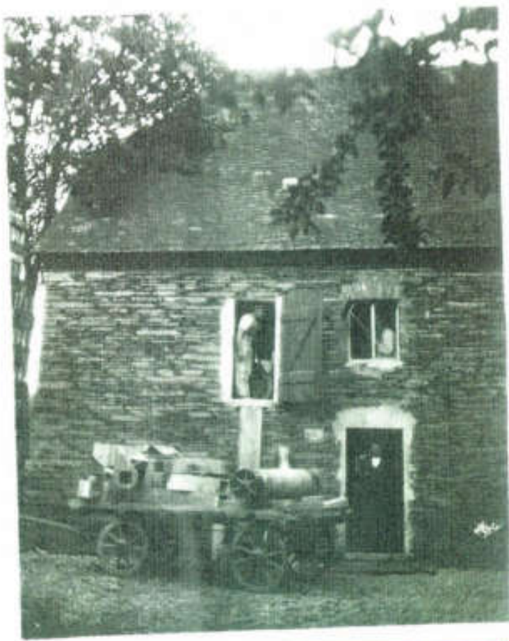
Mühlengebäude vor dem Umbau 1924/25
