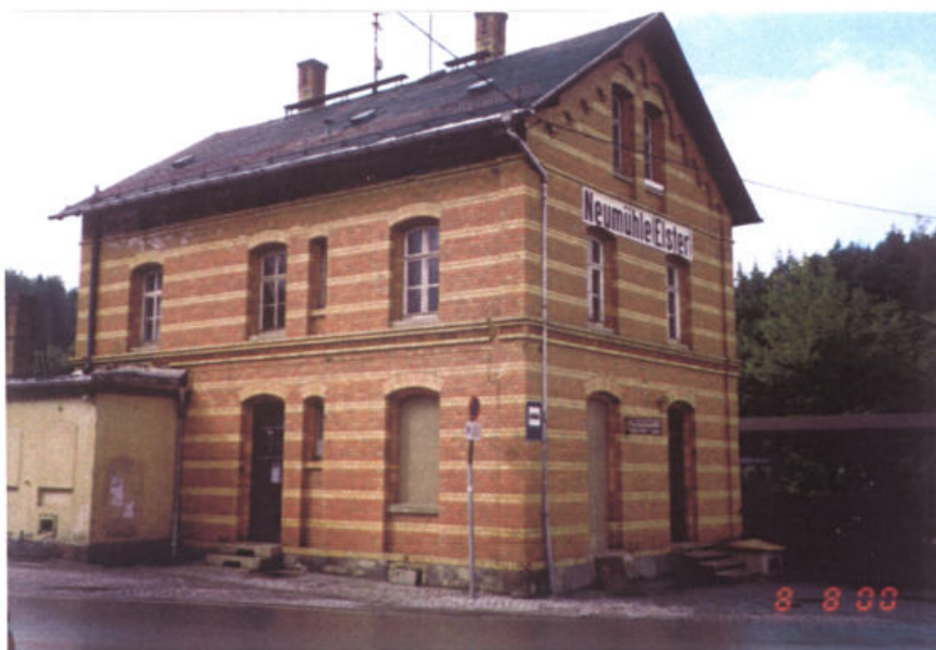
Bahnhofsgebäude außer Betrieb
