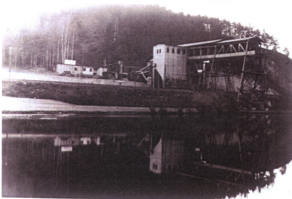
Ende der Drahtseilbahn an der Verladestation, daneben eine Teermischanlage
